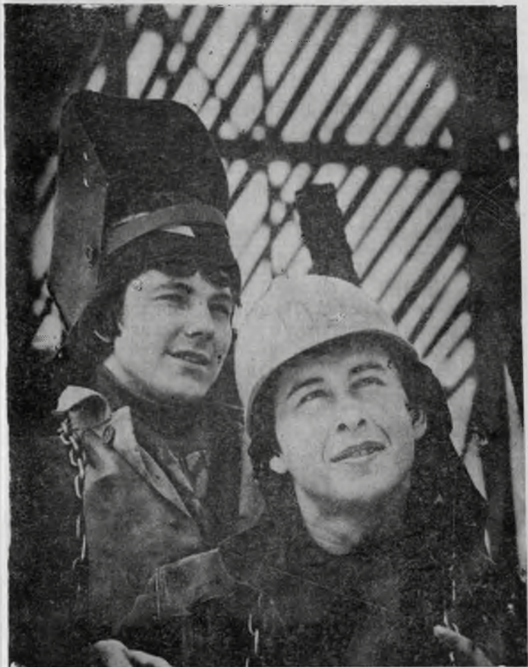
Сварщик-монтажник А. Яковлев и монтажник И. Кудряшов из бригады Н. Митрофанова Волго-Камского участка треста «Гидромонтаж» отлично трудятся на строительстве ГЭС.
