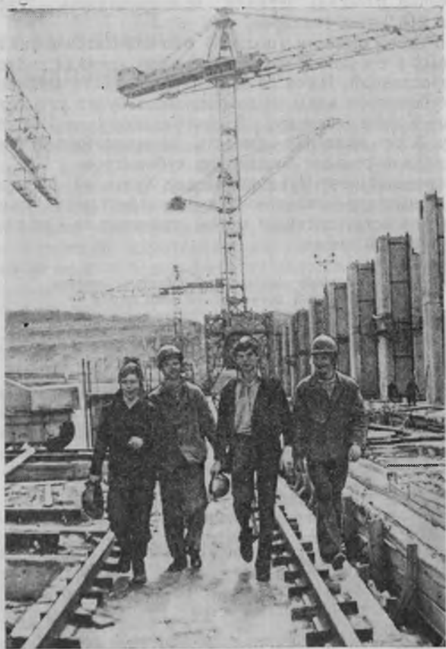
Монтажники плотины ГЭС из бригады А. Лапцелича пользуются доброй славой.
